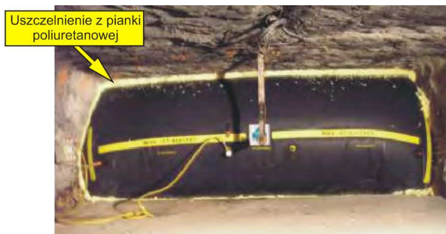
Rysunek 9.7. Podziemne badania dmuchanego urządzenia wentylacji tymczasowej
